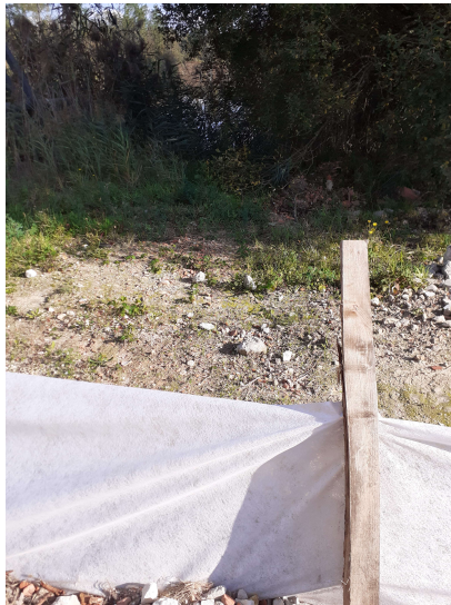
Bâche pour empêcher le passage des amphibiens de la lagune vers le chantier
